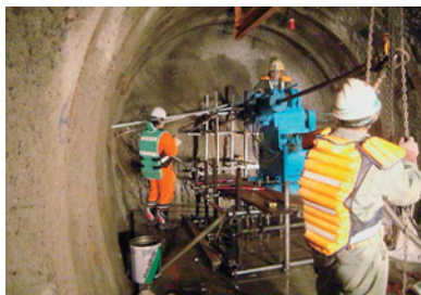
坑道内でのボーリング掘削状況
